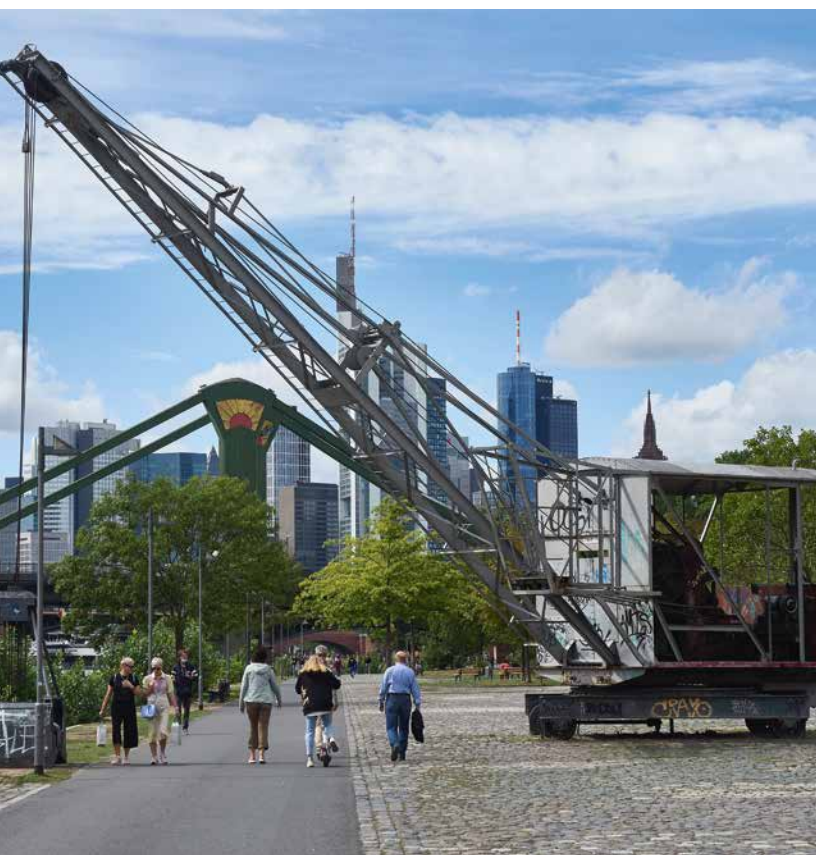
← Historischer Hafenkran auf der ‚Weseler Werft‘.
